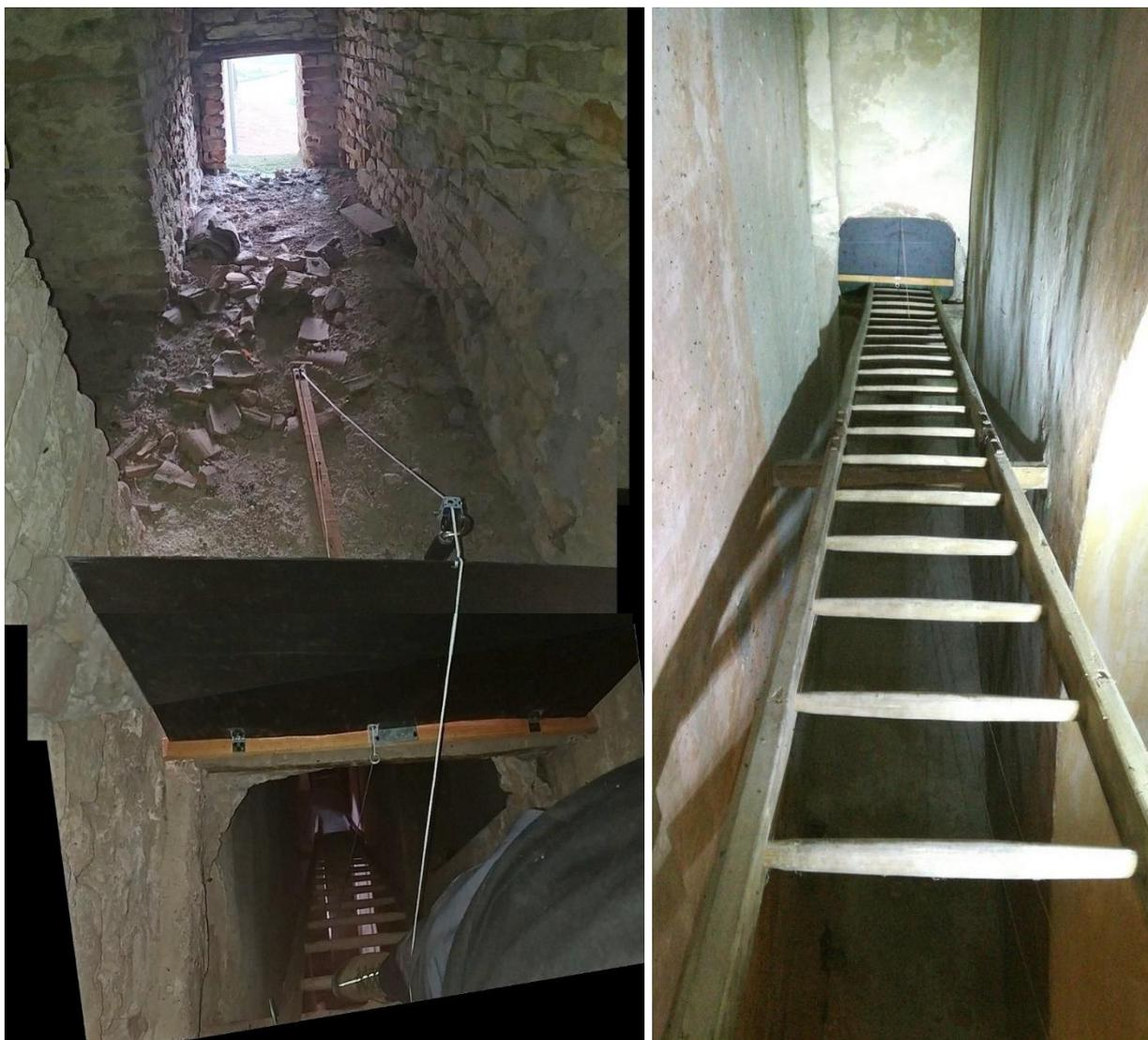
**Fig. 8. Il sistema temporaneo di chiusura e riapertura della botola che dà accesso al sottotetto principale, realizzato in funzione degli eventi per stimolare l'utilizzo, da parte dei chiroterri, della nuova via di transito.**
