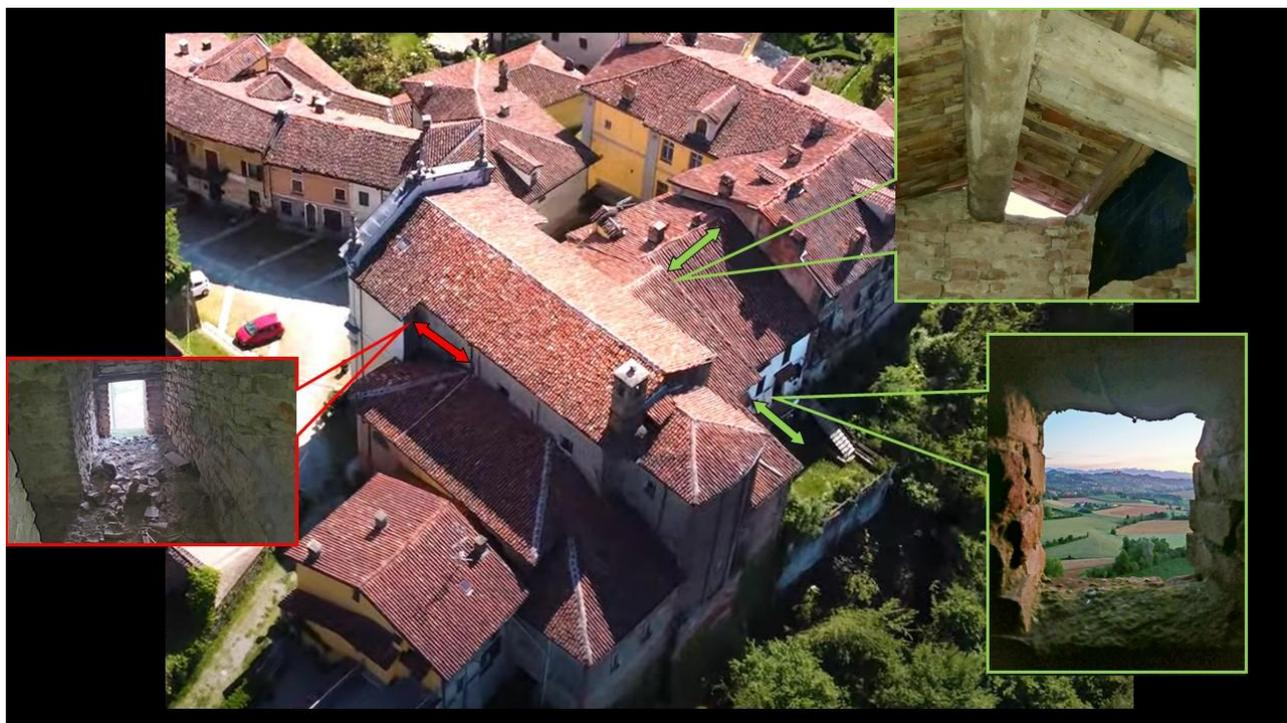
Fig. 10. Nel riquadro rosso, il vecchio accesso utilizzato dai chiroterri, da cui possono ancora accedere al sottotetto principale, ma non all'interno della chiesa. Nei riquadri verdi, i nuovi accessi.
