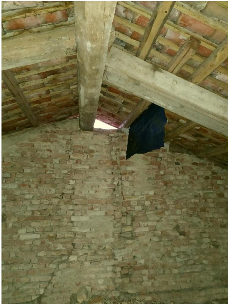
**Fig. 2.** L'apertura realizzata nel 2016 nel sottotetto adiacente al vano dedicato alla colonia, allo scopo di fornire ai chiroggeri un accesso alternativo, che non comportasse il transito nelle parti della chiesa destinate alla fruizione antropica. A lato dell'apertura è stato collocato un pannello di stoffa spessa, finalizzato ad agevolare l'individuazione dell'accesso.
