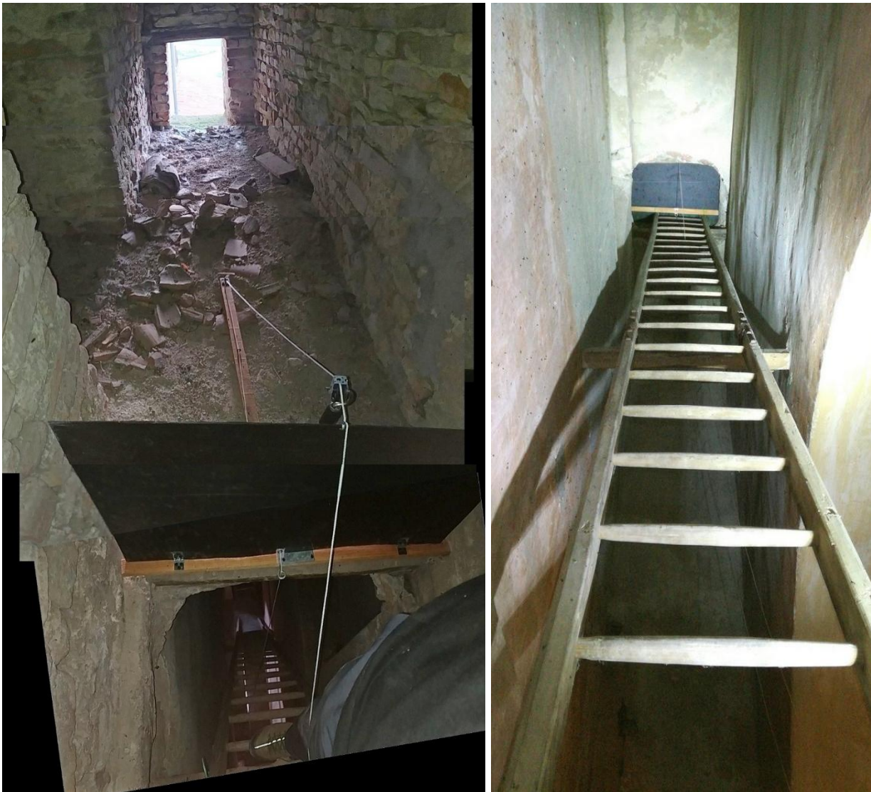
Fig. 5. Il sistema temporaneo di chiusura e riapertura della botola che dà accesso al sottotetto principale, realizzato in funzione degli eventi per stimolare l'utilizzo, da parte dei chiroterri, della nuova via di transito. Nella parte superiore della foto a sinistra si vede l'accesso tradizionale utilizzato dagli esemplari della colonia.
